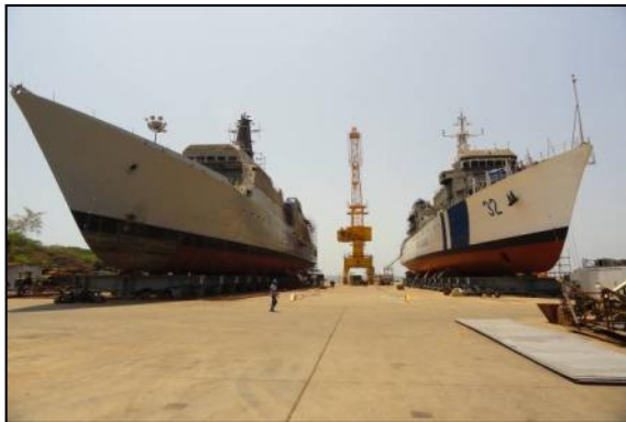
Berços de Construção
